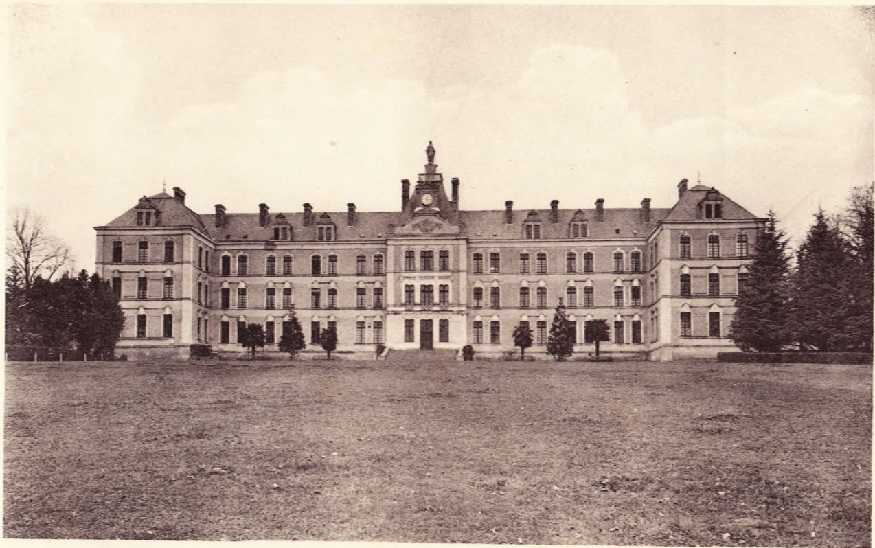
FAÇADE DU COLLÈGE
