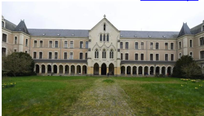
L'établissement catholique de Combrée (Maine-et-Loire), qui est fermé depuis 2005.
